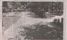
Okulumuzun karşısında bulunan parkımızın içinde aşıp yürümeye yolu yapılmıştı. Ancak bu aşıp döşemeler zamanla deforme olmuş ve kırılmıştır. Şehzadeler Belediyesi Fen İşleri Müdürlüğüne bağlı ekiplerimiz, oradaki döşemeyi komple kaldırarak onun yerine 21 bin liraya mal olan ve 142 metrekare kompozit deck kaplama döşemesi yapıyoruz. Hem uzun ömürlü olması hem de aynı aşıp görüntüsünde kalsın diye bu çalışmayı başlattık. Vatandaşlarımız daha rahat etmeler diye lüks tesislerde kullanılan bu malzemeyi parkımıza döşeyip, halkımızın hizmetine sunduk. Bu yürüyüş yolunun yapımında emeği geçen tüm arkadaşlarımız çok teşekkür ediyoruz. Halkımıza hayırlı olsun" dedi.
