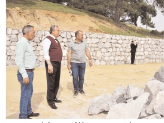
yapının zemin betonu atıldıktan sonra montaj çalışmalarına başlanılacak. Çalışmalar tamamlandıgında Kayapınar Kültür ve Taziye Evi vatandaşlarımızın hizmetine girecek" diye konuştu. -Haber Merkezi
