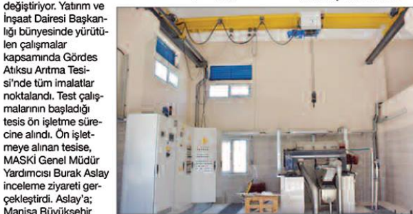
MANİSA Büyükşehir Belediyesi Manisa Su ve Kanalizasyon İdaresi Genel Müdürlüğü, çevreci yatırımları ile Manisa'nın kaderini değiştiriyor. Yatırım ve İnşaat Dairesi Başkanlığı bünyesinde yürütülen çalışmalar kapsamında Gördes Atıksu Arıtma Tesisi'nde tüm imalatlar noktalandı. Test çalışmalarının başladığı tesis ön işletme sürecine alındı. Ön işletmeye alınan tesise, MASKİ Genel Müdür Yardımcısı Burak Aslay inceleme ziyareti gerçekleştirdi. Aslay'a; Manisa Büyükşehir
