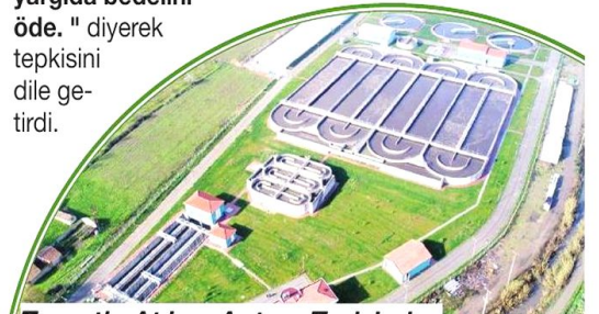
Turgutlu Atıksu Arıtma Tesisinde
