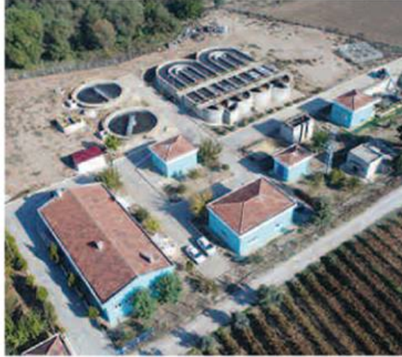
2016 yılında 22 milyon metreküp atıksu arıtılarak, Gediz ve Kuzey Ege Havzalarının kurtarılması yolunda önemli bir adım atıldı. 2017'de inşası tamamlanarak devreye alınan Turgutlu, Soma ve Gördes atıksu arıtma tesislerinin yanı sıra, Manisa merkez atıksu arıtma tesisi'nin inşası da 2018 yılı içinde tamamlanarak ön işletmeye alınacak. 2018 yılında MASKİ bünyesinde işletilmeye başlanacak olan bu 4 tesis ile birlikte, 51 milyon metreküp daha atıksu arıtılarak 73 milyon metreküp atıksuyun sağlıklı bir şekilde doğaya salınması hedefleniyor.
