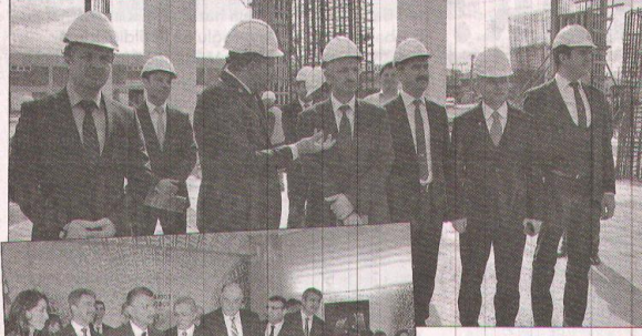
MANİSA Valisi Erdoğan Bektaş, Turgutlu ilçesinde yapımı devam eden spor salonu ve stadyum inşaatlarını inceledi.
