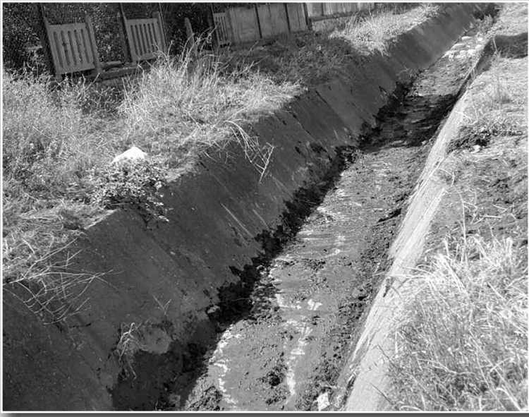
MANISA Su ve Kanalizasyon İdaresi (MASKİ) Genel Müdürlüğü, il genelinde dere yataklarında başlattığı temizlik çalışmalarını aralıksız
