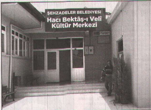
Şehzadeler Belediyesinin Yeniköy Mahallesinde yaptığı Hacı Bektaş-ı
