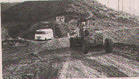
Manisa Büyükşehir Belediyesi Yol Şube Müdürü Fevzi Demir, çalışmalarını yerinde incelemek amacıyla Turgutlu ilçesini ziyaret etti. Çatakköprü ve Kayrak Mahalleleri arasında tehlike arz eden virajda yürütülen yol genişletme çalışmasını da inceleyen Demir, can kaybı ve maddi hasarların meydana geldiği araç kazalarını ortadan kaldırmak için mevcut çalışmanın hassasiyetle yürütüldüğünü söyledi. Kayrak-
