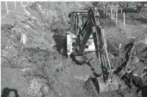
MANISA Su ve Kanalizasyon İdaresi (MASKİ)
