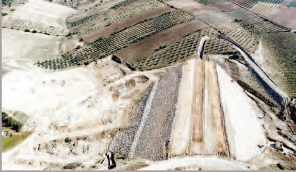
Alaşehir Gülpınar Mahallesi'nin 700 metre güneyindeki Carta Deresi üzerinde süren inşaat
