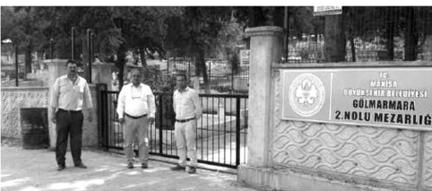
GÖLARMARA merkez 2 no'lu mezarlığının çevre duvarı ve kapı
