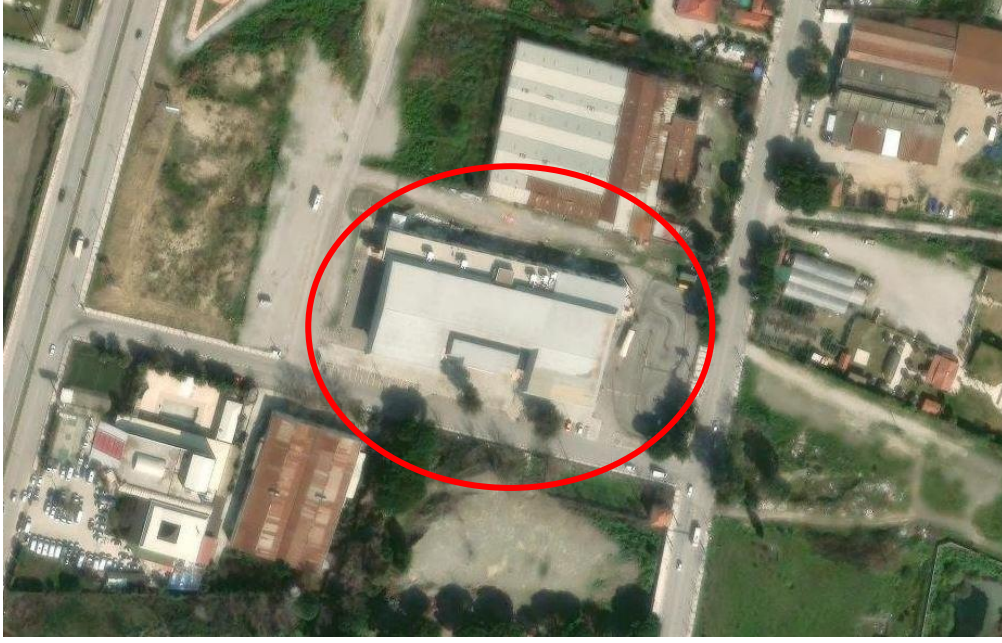
Mevcut Durumu Gösterir Hava Fotoğrafi-2
