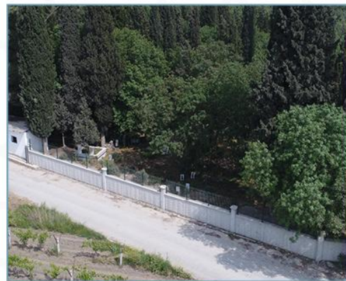
Mezarlık Çevre Duvarı
