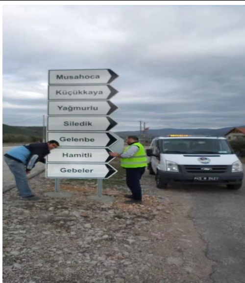
İlçe ve Mahalle yollarına yapılan yön levhaları
